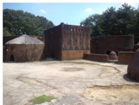
Casa de barro dos Kassena (Burkina Faso)
